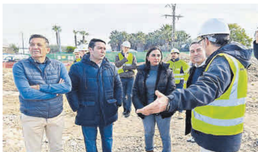
Imagen de la consejera durante la visita a las obras.
